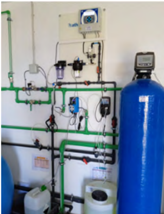
Equipo Descalcificador de Potables
